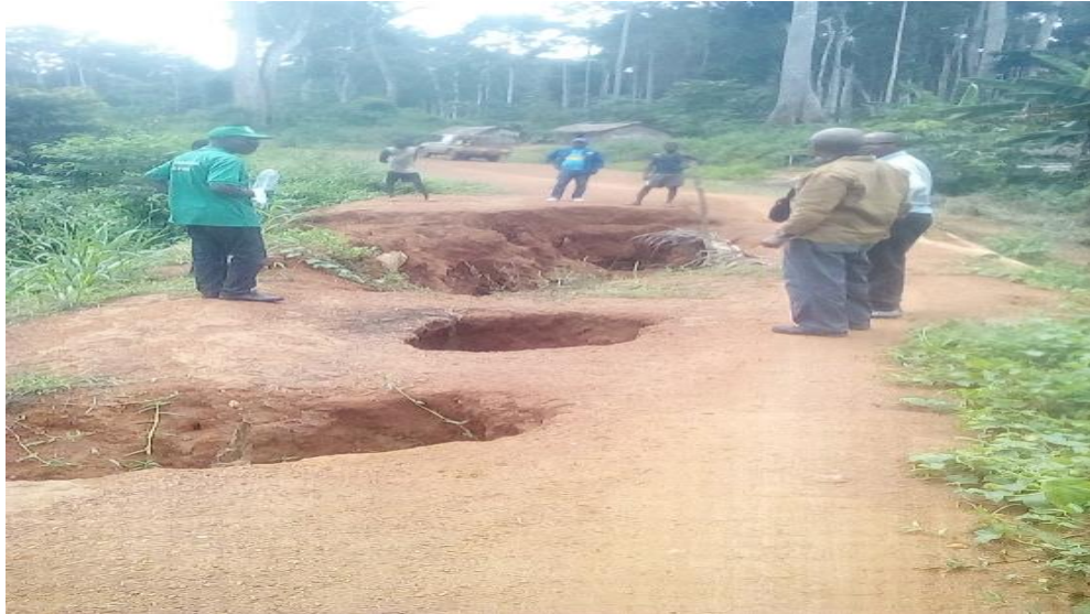
Figure : Pont non démantelée après fermeture de l'AAC
