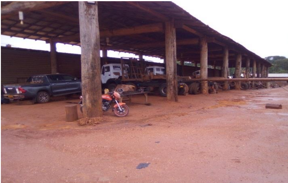
Figure 26 : Vue du garage
