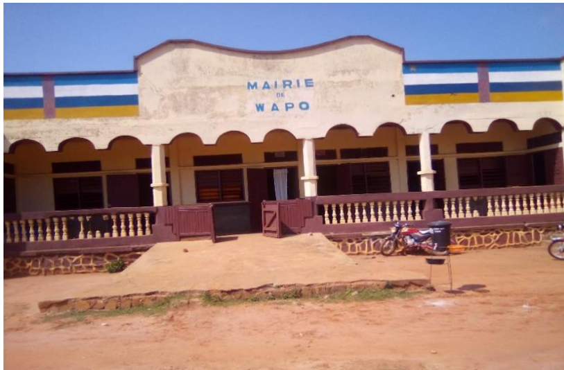
Figure 13 : Mairie de la Commune de Wapo
